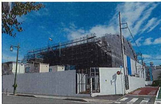
市民ホール建設現場 2019(平成31)年に工事開始
